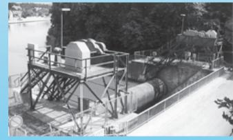
1903 erstmals von der Firma MAN als Verschlusseinrichtung sowohl für den Grundablass als auch für das Überfallwehr im Hauptarm des Mains zur Regulierung des Wasserstandes und ungefährlichen Eisabführung eingesetzt. Der besondere Vorteil des Walzenwehrs lag in der leichten Beweglichkeit der ursprünglich 35 Meter langen Walze.
