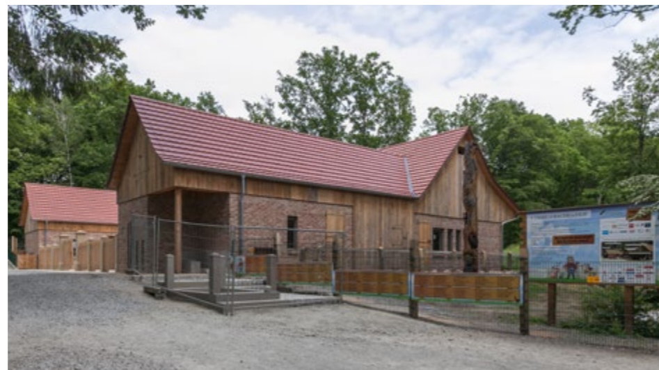
Die Arbeiten am Bauernhof sind fast abgeschlossen. Foto: Stefan Pfister
