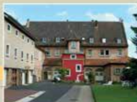
Ehemaliges evangelisches Gemeindehaus Ernst-Sachs-Straße 95 Ausstellung „Made in Schweinfurt“
