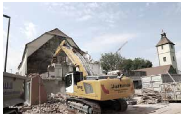
Abriss ehemalige Apotheke. Foto: Stefan Pfister
